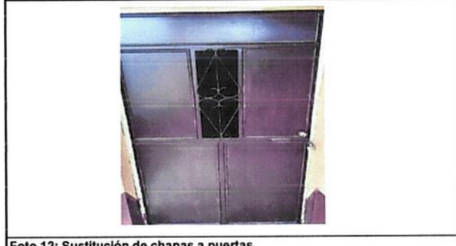
Foto 12: Sustitución de chapas a puertas
