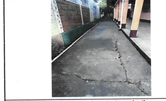
Foto 6: Reparación de planchas de concreto en el patio
