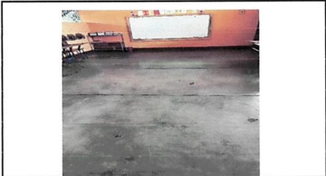
Foto 7: Sustitución de piso cerámico en los módulos A y B sustitución de focos ahorradores, tomacorrientes dobles
