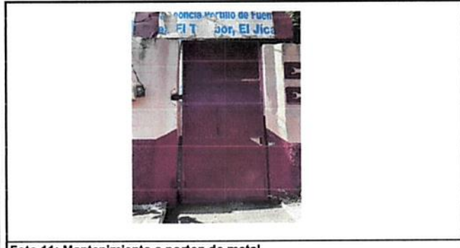
Foto 11: Mantenimiento a porton de metal
