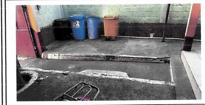
Foto 5: reparación de planchas de concreto en el patio
