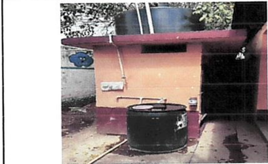
Foto 2: Sustitución de deposito de agua, bomba de agua
