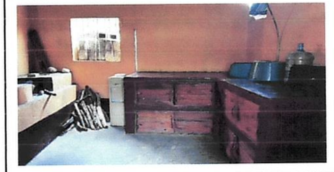
Foto 4: Reparación de azulejo en muebles de cocina, piso cerámico sustitución de focos ahorradores, tomacorrientes dobles
